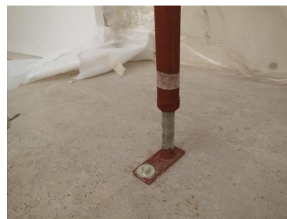
Skruva fast stöttorna i båda ändarna.
