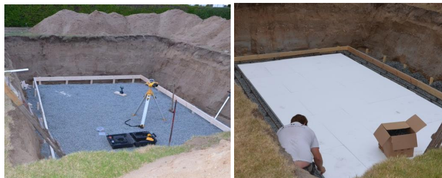
Dräneringslager, gjutform och bottenisolering.
